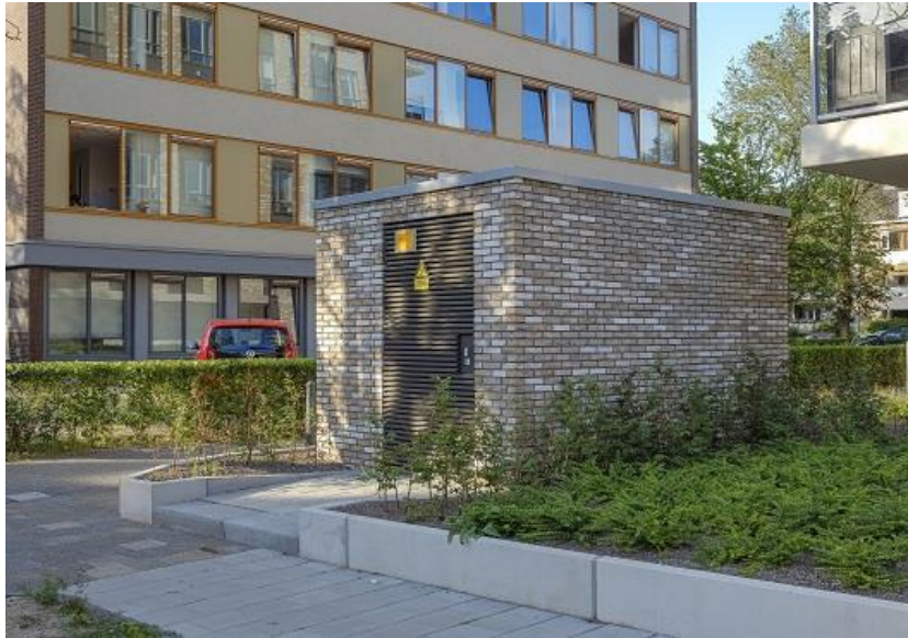
Figuur 5: Transformatorhuisje (bron: Stedin)
